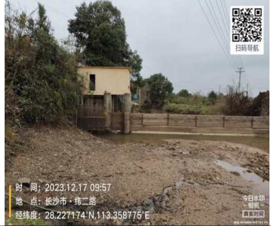
溢流堰上游现状二
