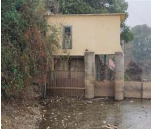
左干渠引水闸
