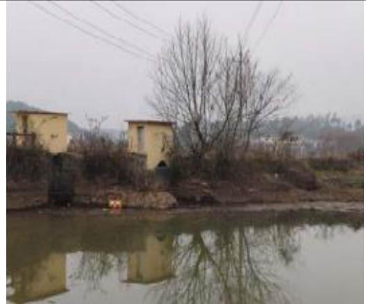
右干渠引水闸和杨家滩干渠引水闸
